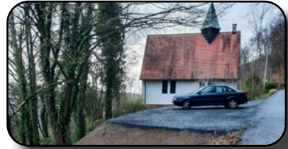
UMBAU- UND REPARATURMAßNAHMEN DER TRINITATISKIRCHE (PARKSITUATION, ZUGANG)
