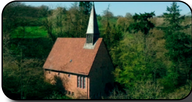
UMBAU- UND REPARATURMAßNAHMEN DER FRIEDENSKIRCHE (OBERER ZUWEG, KIRCHENDACH, INNENAUSSTATTUNG, HEIZUNG)
